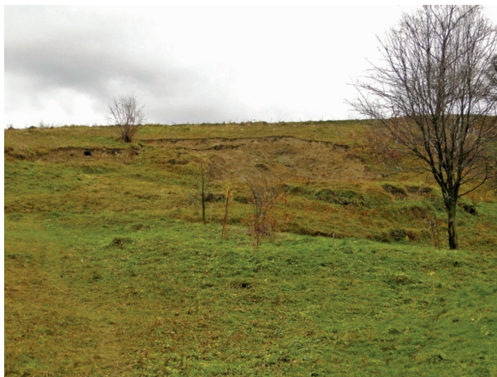
Ryc. 1. Widok ogólny (a) i zbliżenie badanego osuwiska (b) Fig. 1. Overall view (a) and close-up of analyzed landslide (b)
